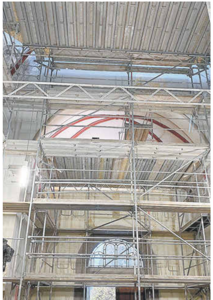
Eindruck von der Baustelle.
