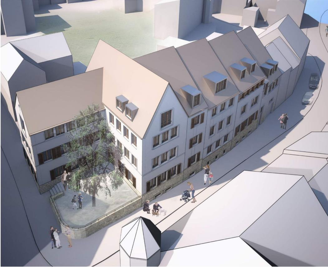
Die Fassade ist als Lochfassade mit stehenden Formaten und durch einen Natursteinsockel und dezent gestaltete Gesimse gegliedert. Gaupen werden in kleinem Maßstab integriert. Die verwendeten Materialien orientieren sich am Bestand und umfassen mineralischer Putz, Naturstein, Holz, Ziegel. Auch die Fassadenfarben orientieren sich am erdigen Farbspektrum der Lutherstraße. Der Einsatz von Fensterläden wird als zusätzliches Gestaltungsmittel genutzt.
