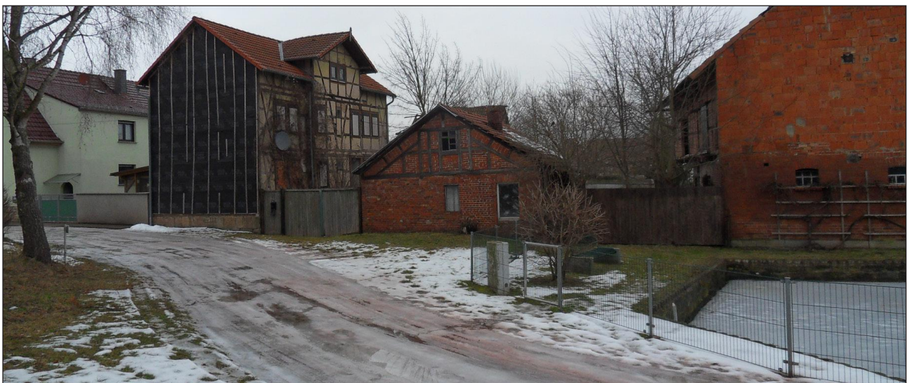
Abb. 26 Baufällige Bestandsbauwerke und Pferdeteich, Quelle: Feistel
