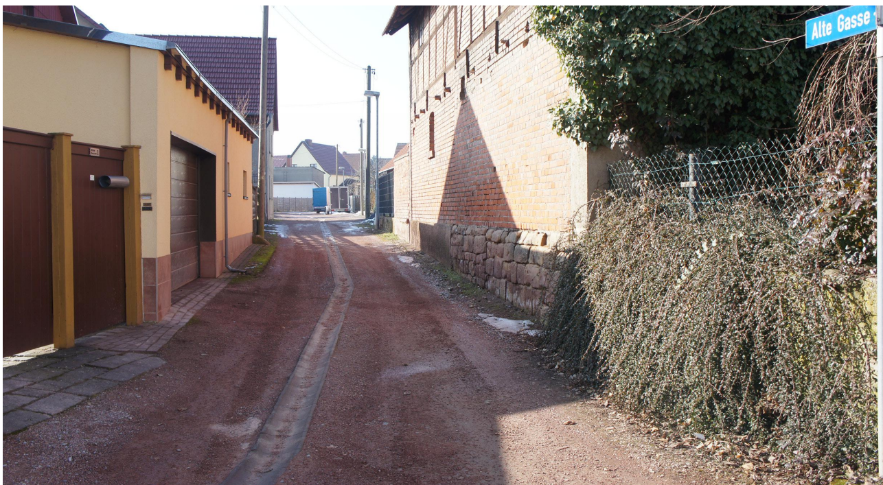
Abb. 36 Unsanierter Straßenzug ‚Alte Gasse‘, Quelle: Eigene Aufnahme
