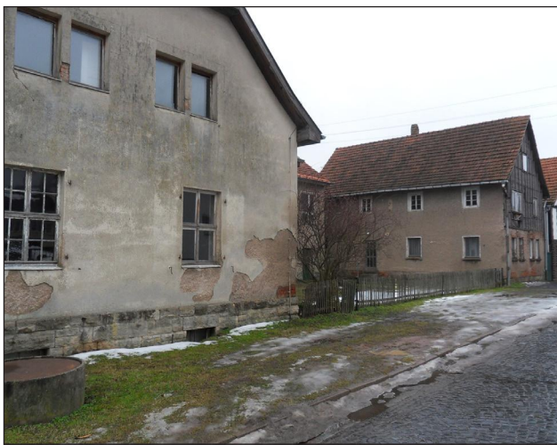
Abb. 20 Straßenansicht U-förmiges Gebäudeensemble, Quelle: Feistel
