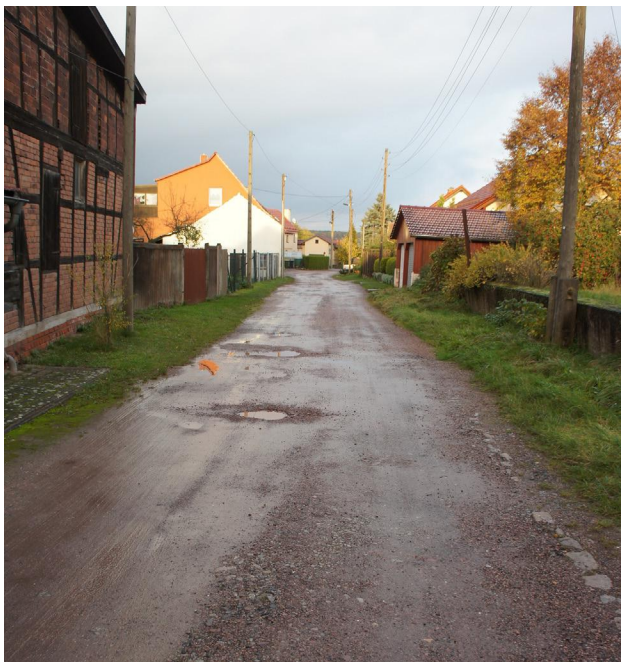
Abb. 37 Unsanierter Straßenzug ‚Am Teich‘, Quelle: Eigene Aufnahme
