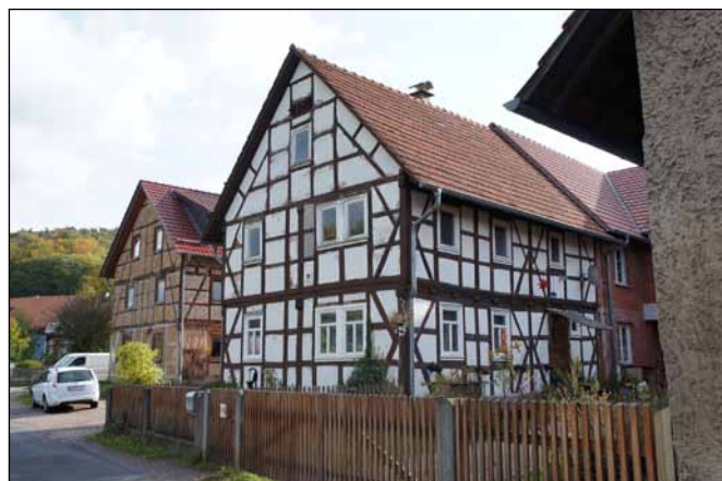
Abb.43.: Ortsbildprägende Fachwerkhäuser, Quelle: Eigene Aufnahme
