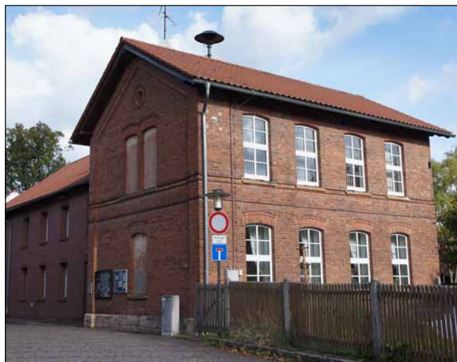
Abb.25.: Dorfgemeinschaftshaus im Schulplan Neuenhof, Quelle: Eigene Aufnahme
