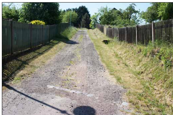
Abb.60.: Zustand Brennergasse Görlingen, Quelle: Eigene Aufnahme
