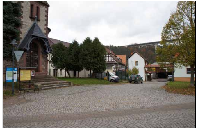
Abb.50.: Vorplatz der Kirche, Quelle: Eigene Aufnahme
