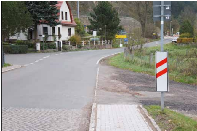
Abb.69.: Fehlende Gehwegeverbindung in Hörschel, Quelle: Eigene Aufnahme
