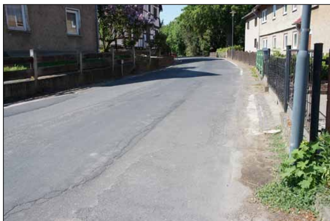
Abb.68.: Warthaer Straße Neuenhof, Quelle: Eigene Aufnahme
