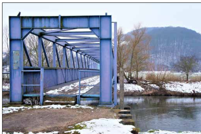
Abb.101.: Fußgängerbrücke in Richtung Göringen Quelle: Eigene Aufnahme
