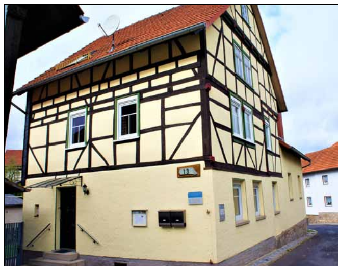
Abb.23.: Vereinshaus Landleben e.V. Wartha-Göringen, Quelle: Eigene Aufnahme
