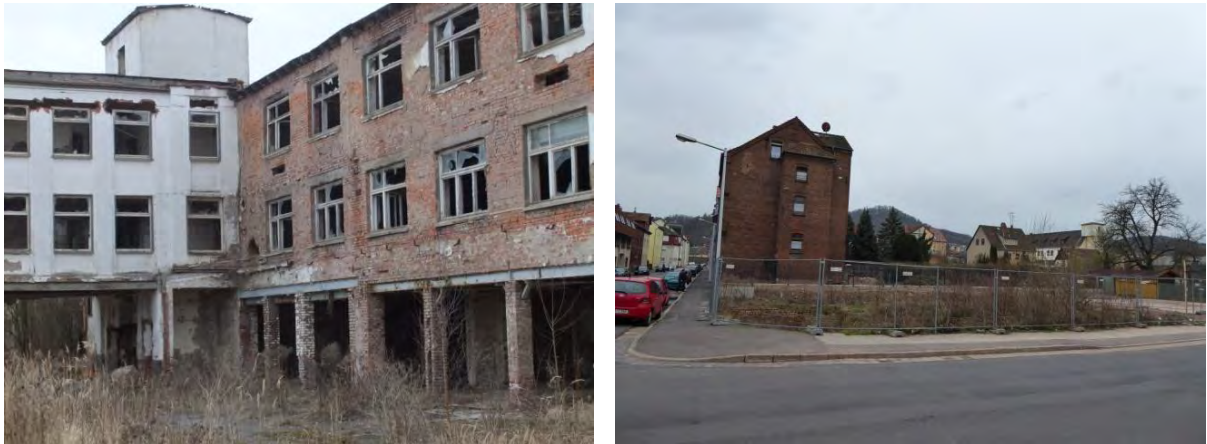
Abbildung 47 / 48 Verfallene Gebäude und Brachflächen im Stadtteil Oppenheimstraße
