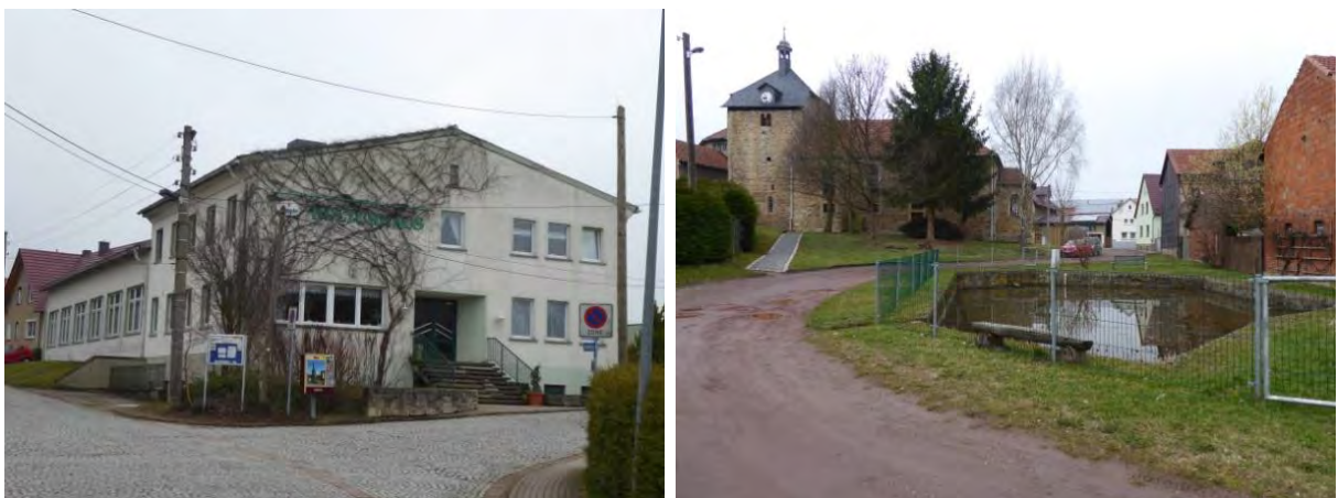
Abbildung 105 / 106 Das Kulturhaus (links) und unversiegelte Straße im Ortskern (rechts)
