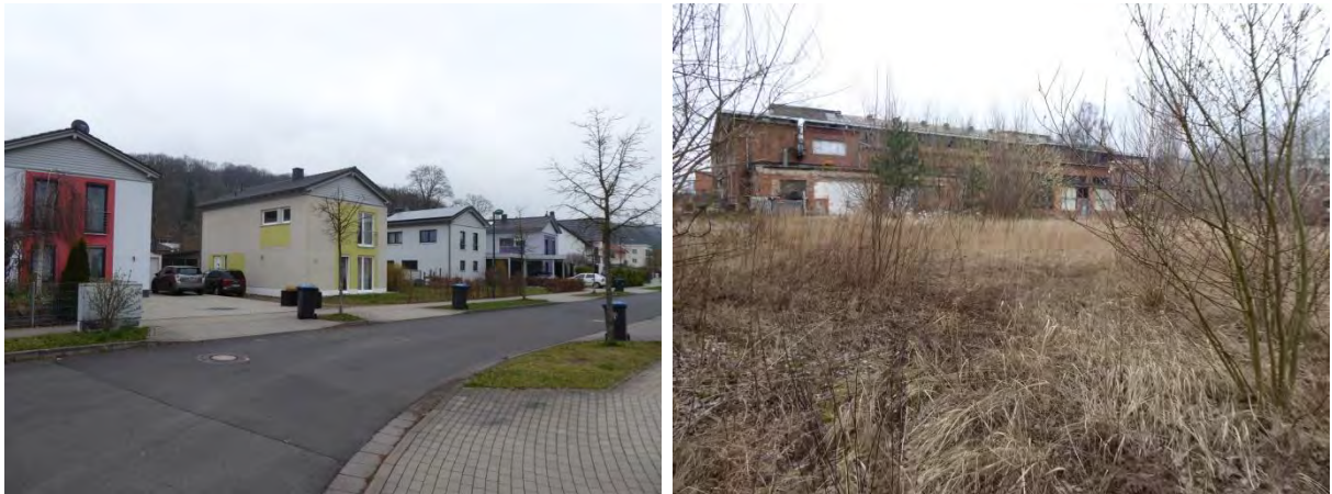
Abbildung 79 / 80 Erfolgreiche Revitalisierung durch Neubau von Wohnungen (links) und verbleibende Brachflächen (rechts) auf dem ehem. AWE-Gelände
