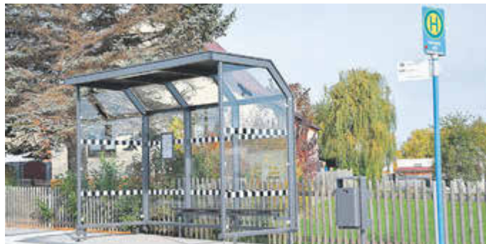
Ein neuer Kreisverkehr im Eisenacher Ortsteil Stregda entspannt den Verkehrsfluss im Bereich mehrerer großer Märkte spürbar. Unweit des neuen Kreisverkehrs sind zwei Bushaltestellen barrierefrei ausgebaut worden.
