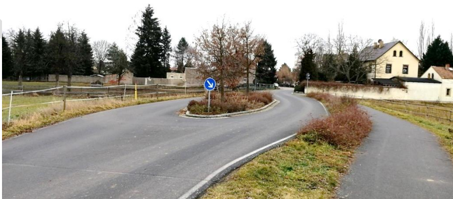
Foto: Beispiel für eine Fahrbahnaufweitung im Ortseingangsbereich
