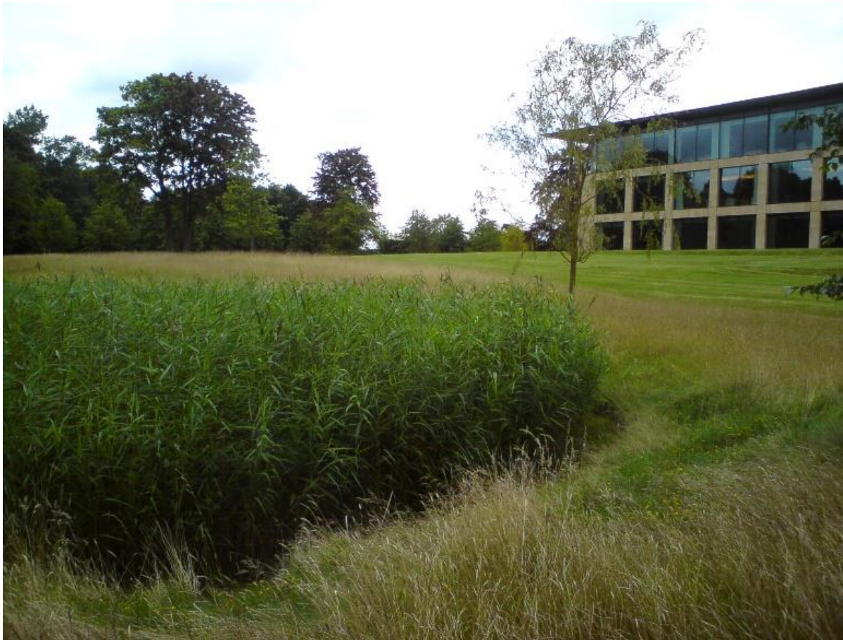
Abbildung 27: Links oben: Filterrinne an Grundstücksgrenze – Berlin Friedrichshain; Rechts oben: Randstein mit Lücke und Muldenstein – Hoppegarten; Unten: Bewachsener Bodenretentionsfilter – Hoppegarten Industriegebiet
