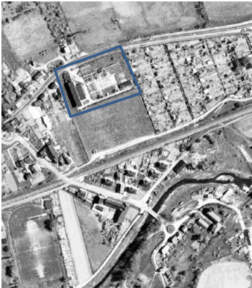
Abb. 6: 1980-05-13_0251* Umspannstation auf Flurstück vorhanden
