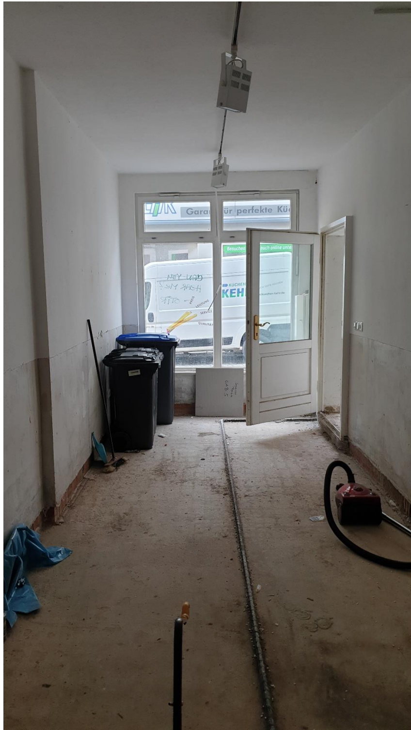
Abbildung 2: Innenansicht mit Schaufenster Richtung Frauenberg
