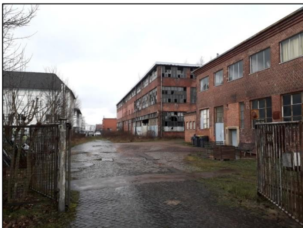
Werksgelände O1, mit Vereinsgebäude im Vordergrund
