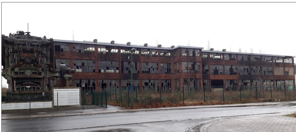
Werksgebäude O1, Straßenansicht Friedrich-Naumann-Straße
