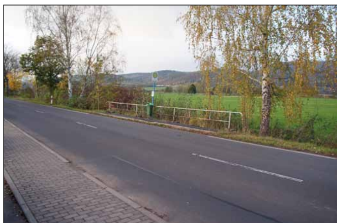
Abb.84.: Bushaltestelle Göringen, Quelle: Eigene Aufnahme
