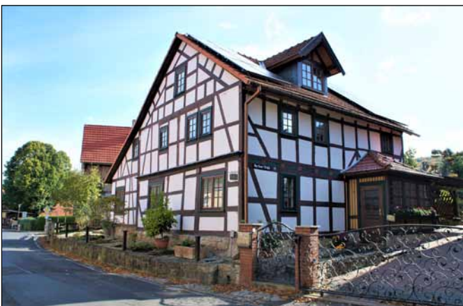
Abb.38.: Ortstypisches Fachwerkhaus, Quelle: Eigene Aufnahme
