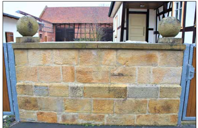
Abb.41.: Sandsteinmauer Wartha, Quelle: Eigene Aufnahme
