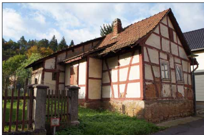
Abb.71.: Leerstand mit ruinöser Bausubstanz in Hörschel, Quelle: Eigene Aufnahme
