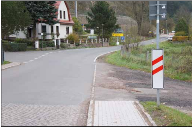
Abb.69.: Fehlende Gehwegeverbindung in Hörschel, Quelle: Eigene Aufnahme
