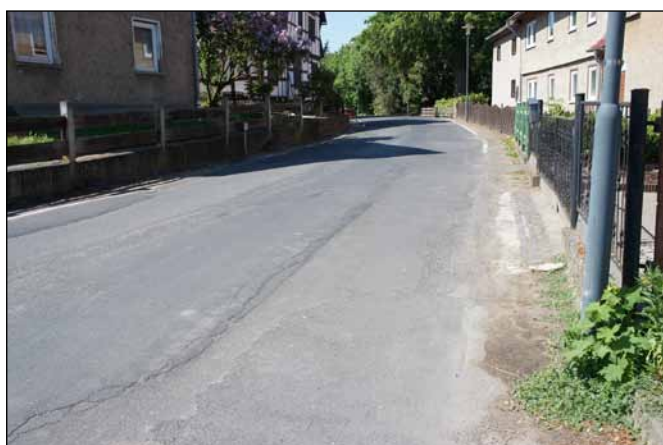
Abb.68.: Warthaer Straße Neuenhof, Quelle: Eigene Aufnahme
