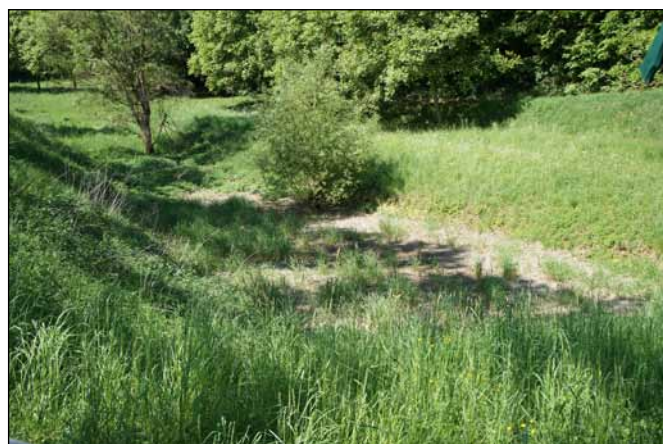
Abb.79.: Hochwasserrückhaltebecken Görlingen, Quelle: Eigene Aufnahme
