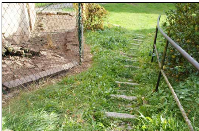
Abb.57.: Treppenaufgang Kirchraingasse Görlingen, Quelle: Eigene Aufnahme
