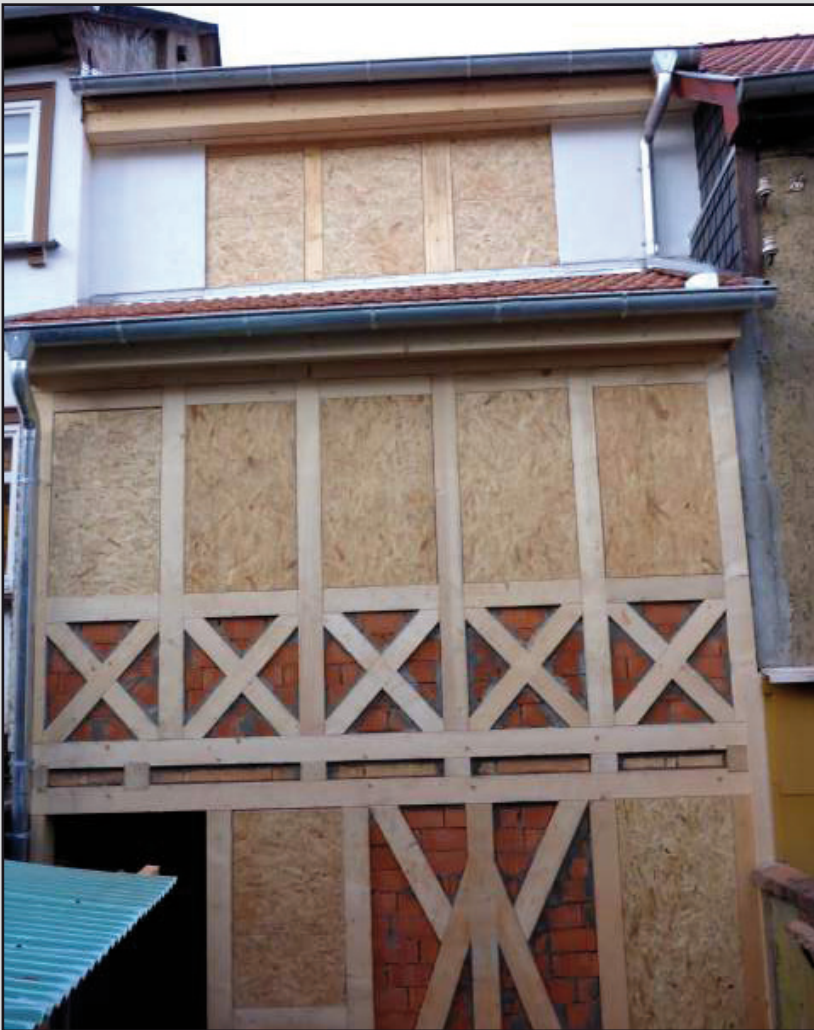
Rekonstruktion rückwärtige Fassade
