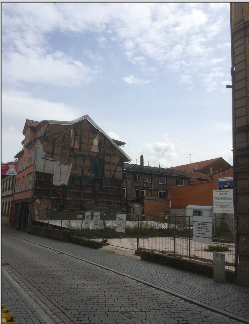
Baulücke Goldschmiedenstraße 18-20 - Ansicht aus Westen mit Sei- tenansicht Goldschmiedenstraße 22
