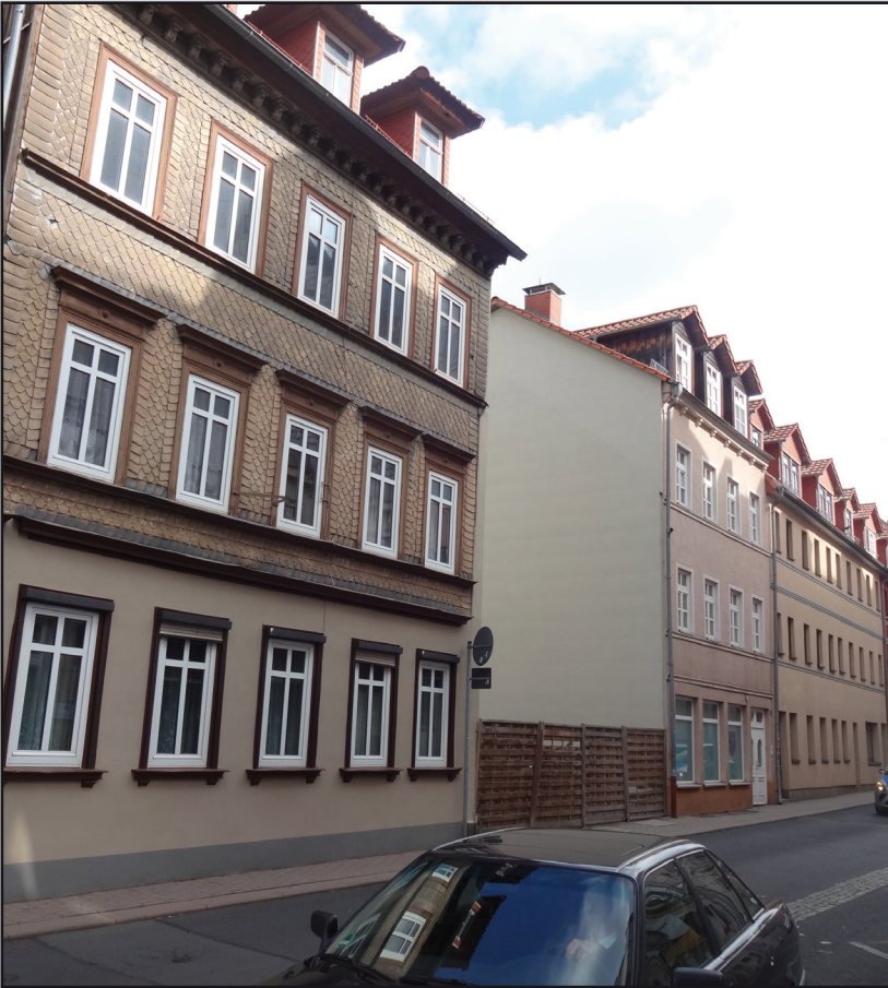
Baulücke Sophienstraße 51 - Ansicht aus Westen mit Seitenansicht auf Sophienstraße 53
