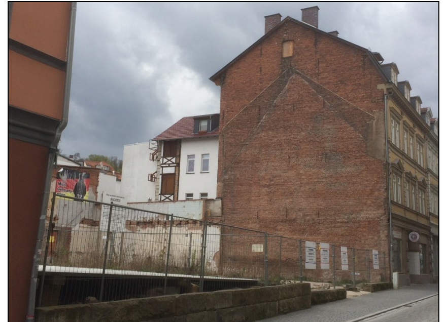
Ansicht aus Osten mit Seitenansicht Goldschmiedenstraße 16
