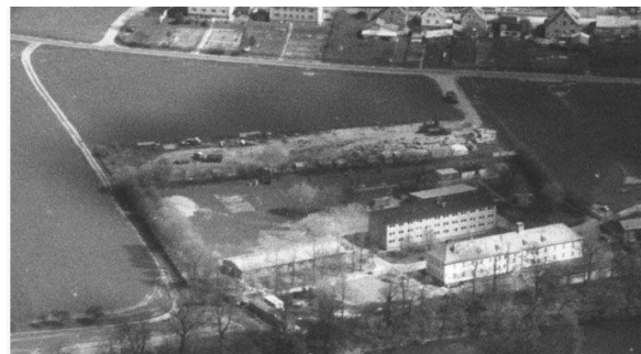
Luftbild von 1985, auf dem die vom Ort etwa abgesetzte Lage recht gut zu erkennen ist.
