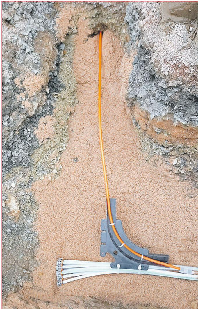
Hier wird ein Hausanschluss am Ende eines Micro-Rohr-Verbundes abgezweigt.
