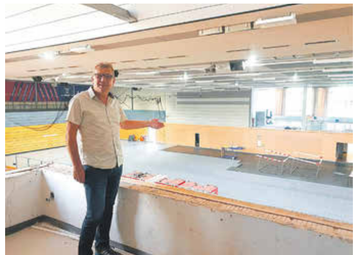
Claus Zuschlag erläutert die Umbaumaßnahmen in der Werner-Äßmannhalle.
